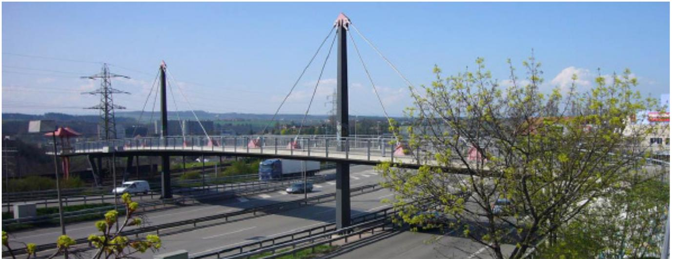
Fig. 17 : La liaison cyclable de 2,4 km de long Berne-Wankdorf-Ittigen (année de construction 1996/97) correspond largement aux standards requis pour les voies express vélo. Les coûts se sont élevés à 4,6 Mio (dont 3 Mio pour les ouvrages d'art). La photo montre la passerelle pour cyclistes au-dessus de l'autoroute.
