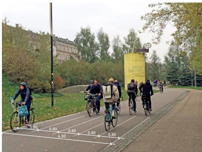
Fig. 15 : Exemple de croisement de cinq vélos : piste cyclable bidirectionnelle de 4 m de large sur « l'itinéraire Nørrebro » à Copenhague (DK). Malgré un TJOM très important (plusieurs milliers de cyclistes) et des vitesses élevées, le niveau de service est très bon. Une juxtaposition pure et simple des gabarits d'espace libre aurait résulté en une chaussée d'au moins 5,60 m de large.
