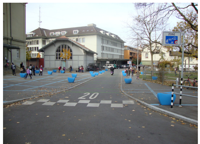
Abb. 10: Selbsterklärende und fehlertolerante Anlage in Form einer Begegnungszone (Turnweg in Bern)
