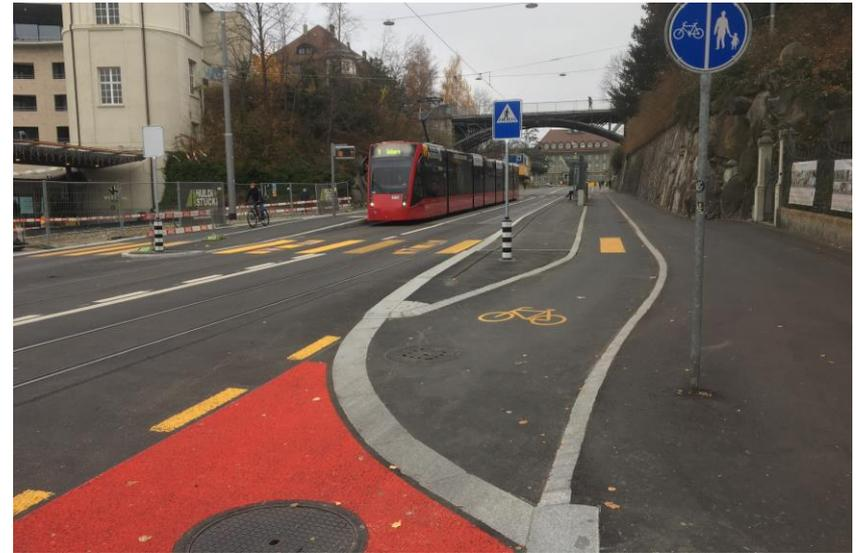
Haltestellenumfahrung: Standardlösung bei Tramhaltestellen und stark frequentierten Bushaltestellen
