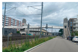
Die neue Fussgängerüberführung über die Strecke der Sihltalbahn wurde direkt über die Allmendstrasse erweitert.
